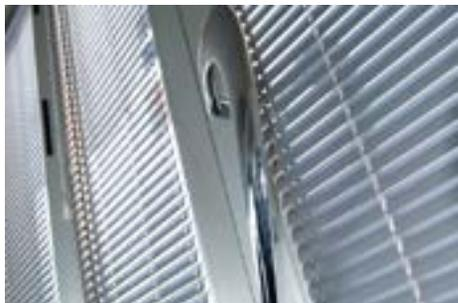
marcas e manchas. Apesar do processo de polimento ser um pouco demorado, essa é uma boa maneira de dar brilho extra às esquadrias. Use lixas d'água para remover as imperfeições. Mas atenção, use óculos de proteção e uma máscara de poeira para cobrir o seu rosto, pois o pó de alumínio é nocivo à saúde.
