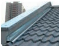
Os rufos são peças moldadas e fixadas para evitar que a água infiltre na alvenaria, assim como o acúmulo de sujeira e infiltrações em sua obra. Em geral, são fixados na divisão de telhas,
