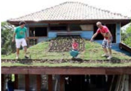
8- Reduz o consumo de energia, e melhora a eficiência energética devido à redução da temperatura no ambiente interno, diminuindo a necessidade de refrigeração. 9- Aumento da biodiversidade, atraindo pássaros, borboletas entre outros. 10- Embeleza a edificação e a cidade. Vantagens e desvantagens de um telhado verde. Veja exemplos.
